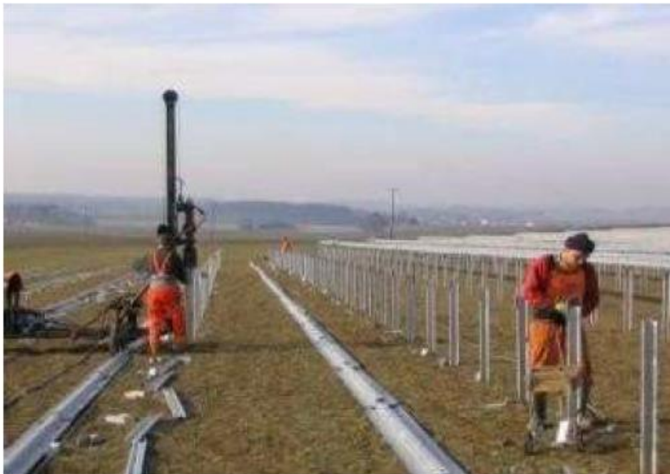
Figura 8 - Fundação com estacas metálicas batidas
